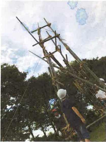
ひもで引る張り上げが建てた様子。
